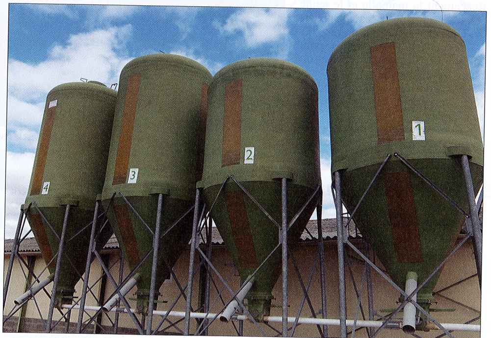
▲ Avec 4 silos, dont l'un dédié à l'aliment engraissement supplémentaire qui concerne toujours le péri-sevrage, Dominique Potiron dispose de près de 50 t de capacité de stockage d'aliment.
